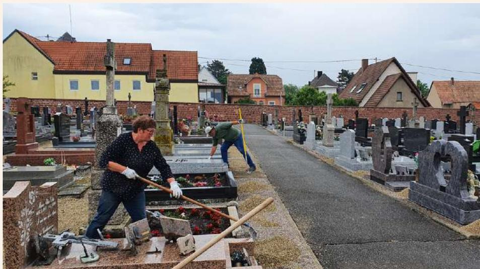
Ces travaux de réfection des allées secondaires consistent à la mise en place d'un revêtement améliorant la stabilité et le confort de marche.
